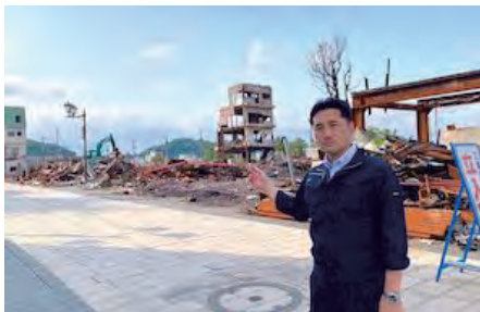
輪島朝市被災現場、部分的に 片付けが始まりました
