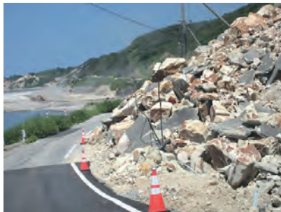
海岸線のいたる所で、土砂・岩石が崩れ応急のう回路が作られており、本格的な復旧工事はいつになるのか？
