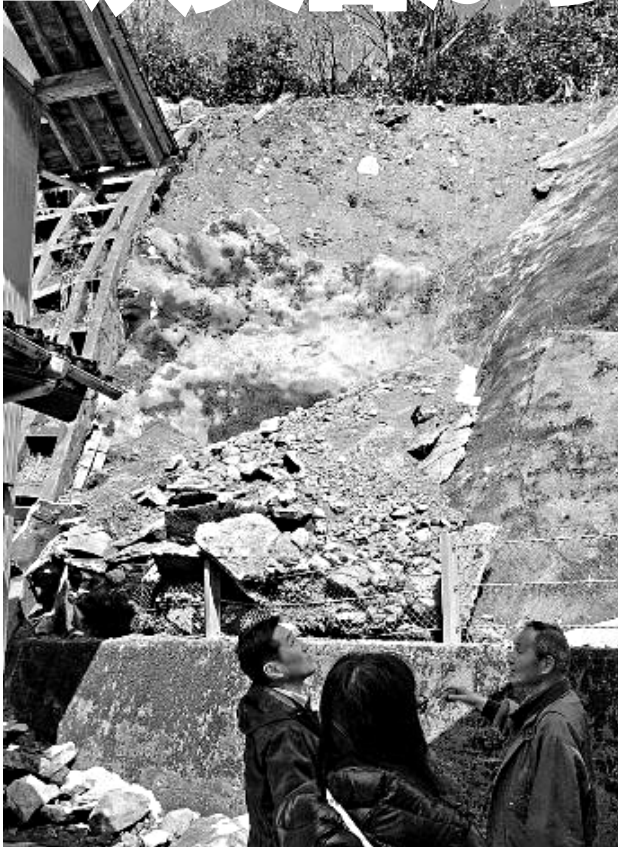
相談が寄せられた K 氏(右)の自宅裏のがけ崩れの現場で調査する藤野責任者(左)ら
