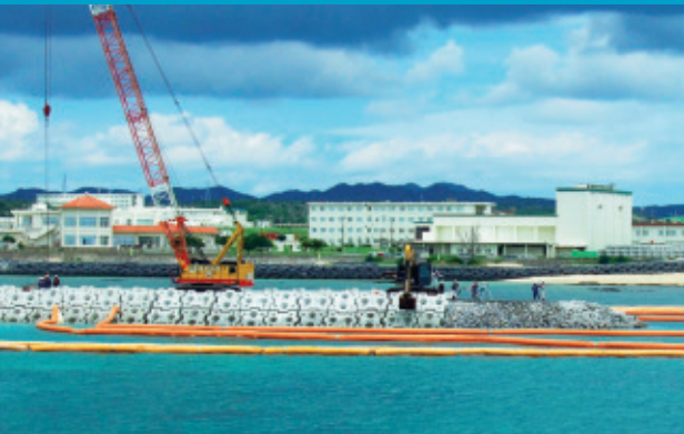
護岸工事が強行されている辺野古沿岸 =6月2日、沖縄県・名護市
