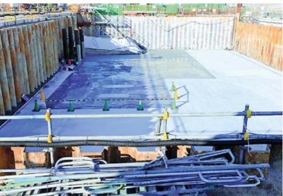
「放水立て坑」の構築状況。上流水槽を収めるための巨大な穴が掘られていました
