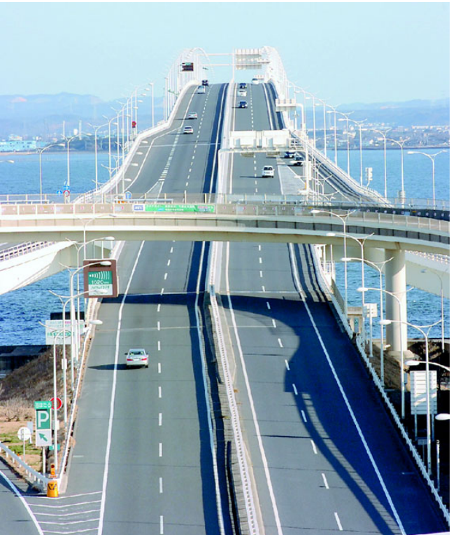
工事費1兆4千億円の東京湾アクアラインは、いつもガラガラ
