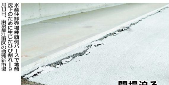
水産卸売場棟西側ハスで地盤沈下のために生じたひび割れ。9月13日、東京都江東区の豊洲新市場
