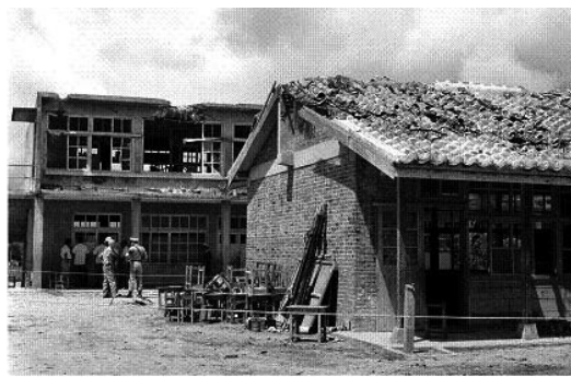
米軍機が墜落し、破壊された宮森小学校の校舎 (キーストンスタジオ提供)
