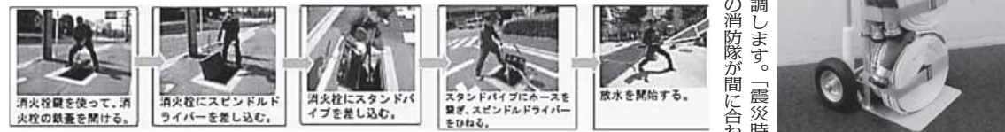
スタンドパイプの使い方—東京都墨田区の資料から
